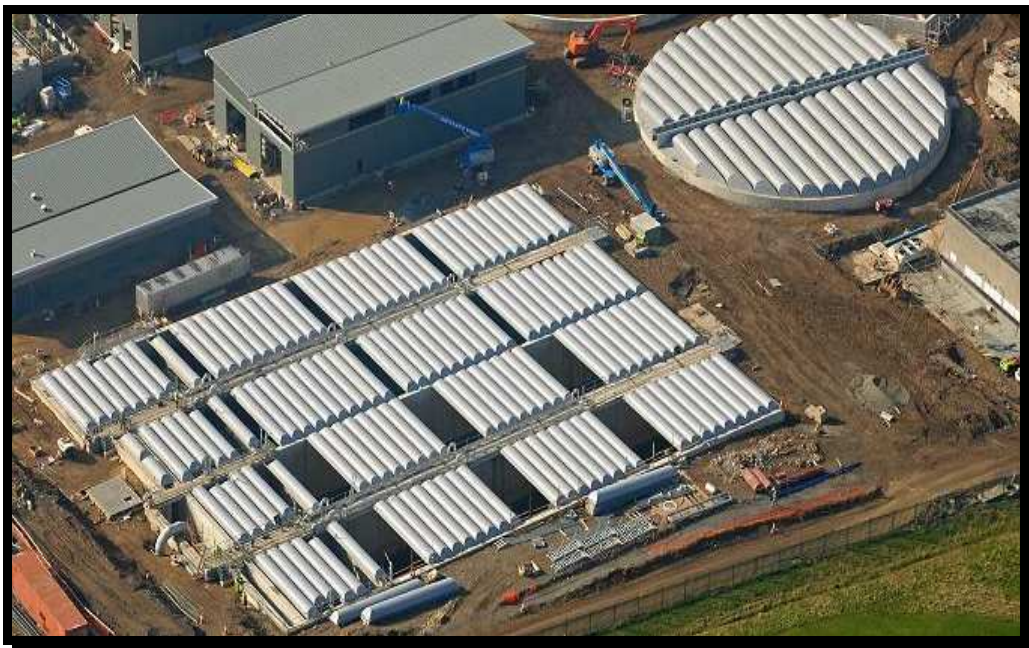
Conjunto de cubiertas rectangulares (36 x 60 m), circulares (d=36 m), cúpulas y planas para planta de tratamiento de aguas residuales.
