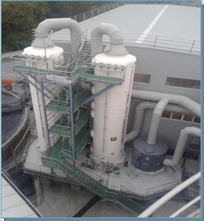
**TECNIUM** se ha adjudicado una nueva **instalación de biotrickling** para una **depuradora urbana** en la Comunidad Murciana. La instalación tratará los olores producidos en la sala de desbaste, la obra de llegada y el pozo de bombeo.
